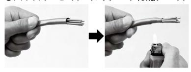
配線、配管の先端のほつれを解消します。 ライター等で加熱するだけできれいに圧着出来ます。 左記のように接着剤は有りません。
